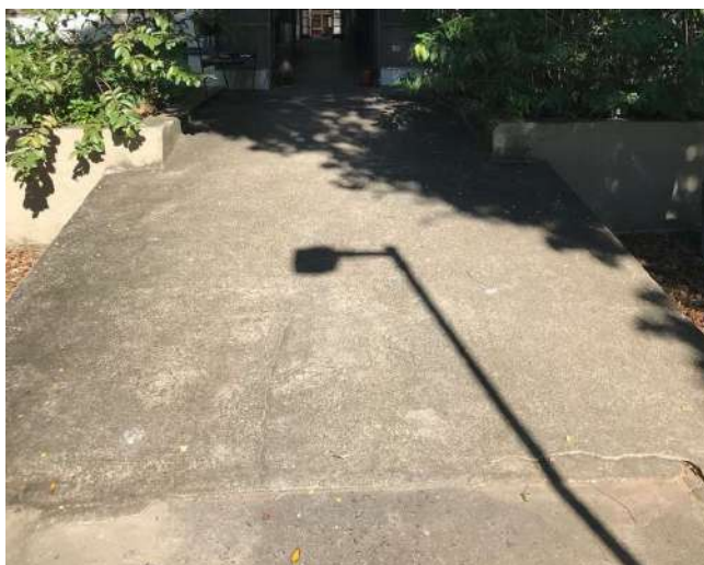
Rampa de escada. Fonte: Autor do laudo.
