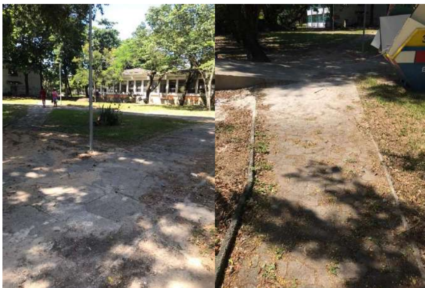
Calçadas e passeios. Fonte: Autor do laudo.
