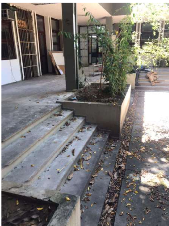
Conjunto de escada localizada no centro da edificação. Fonte: Autor do laudo.
