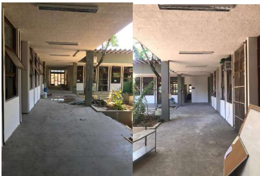
Circulação horizontal do prédio. Fonte: Autor do laudo.
