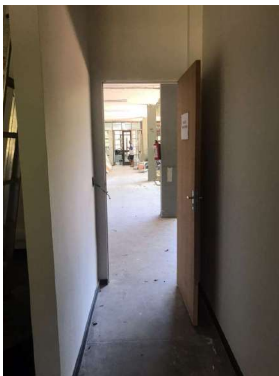
Corredor de acesso interno ao auditório. Fonte: Autor do laudo.
