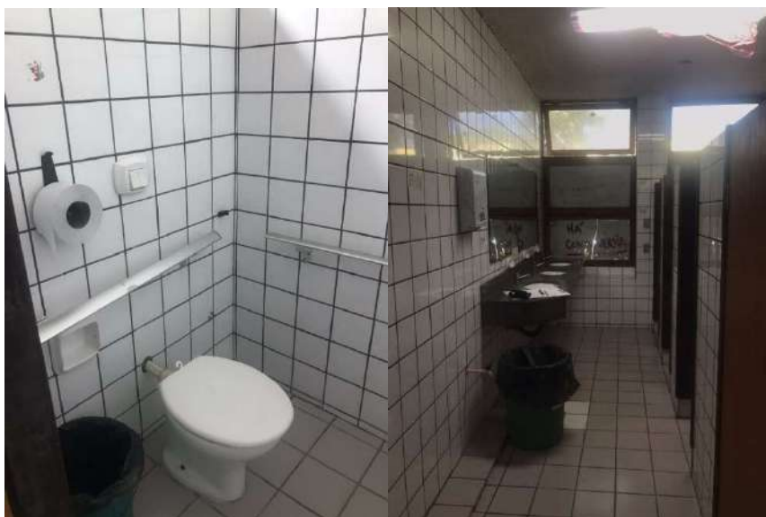
Sanitário acessível feminino. Fonte: Autor do laudo.
