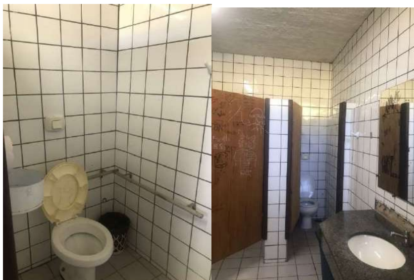
Sanitário acessível masculino. Fonte: Autor do laudo.
