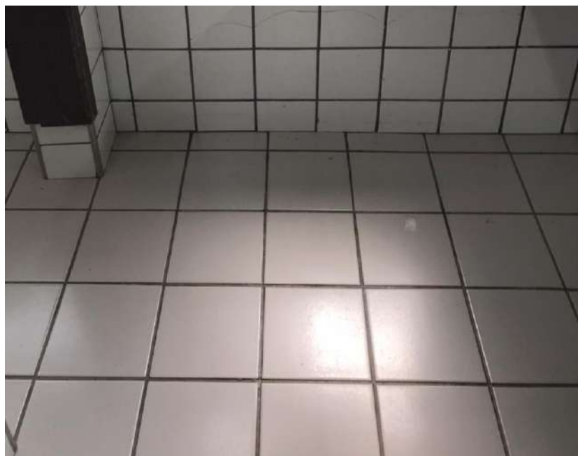
Revestimento do piso do sanitário acessível (Autor do laudo).
