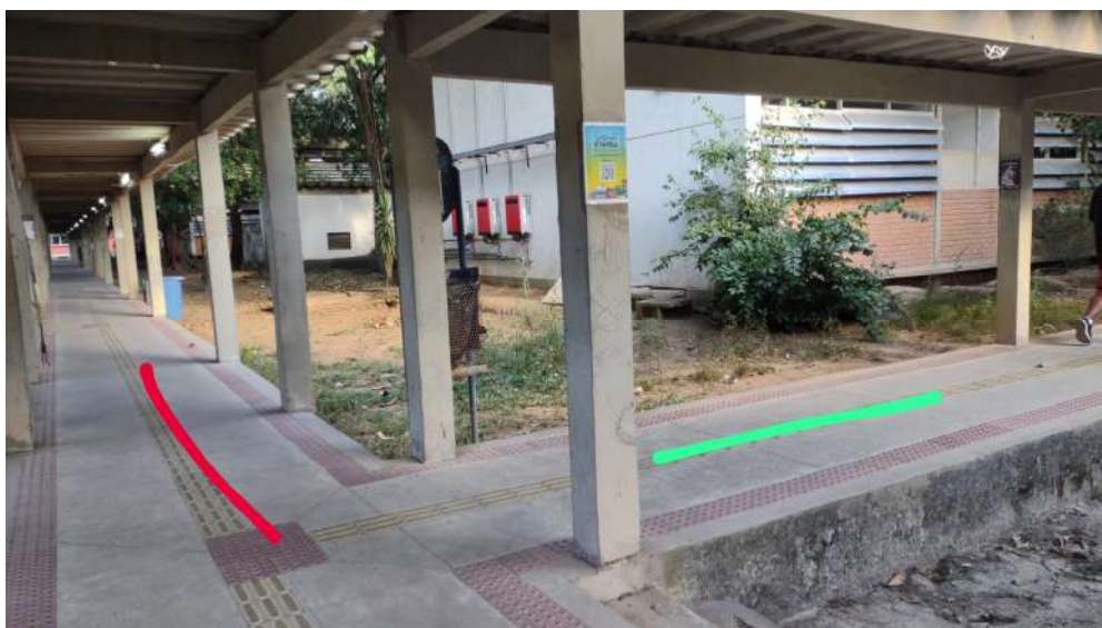
Acessos à edificação. Fonte: Autor do laudo.
