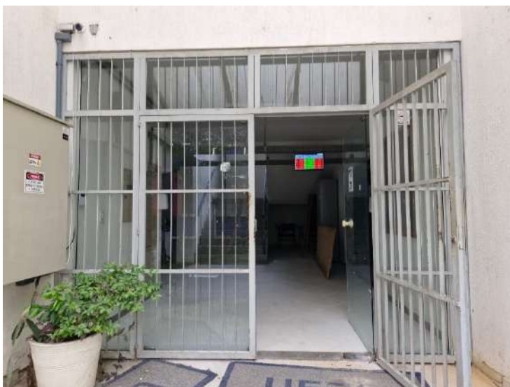
Porta de acesso à edificação (Autor do laudo).
