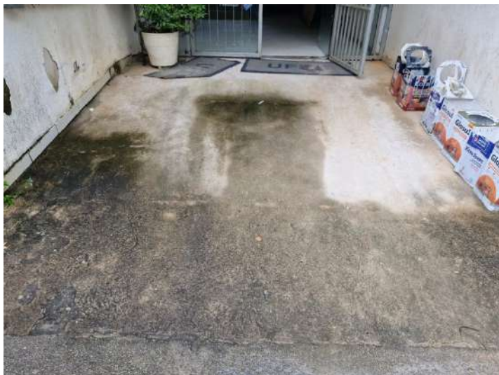
Rampa de acesso a edificação (Autor do laudo).
