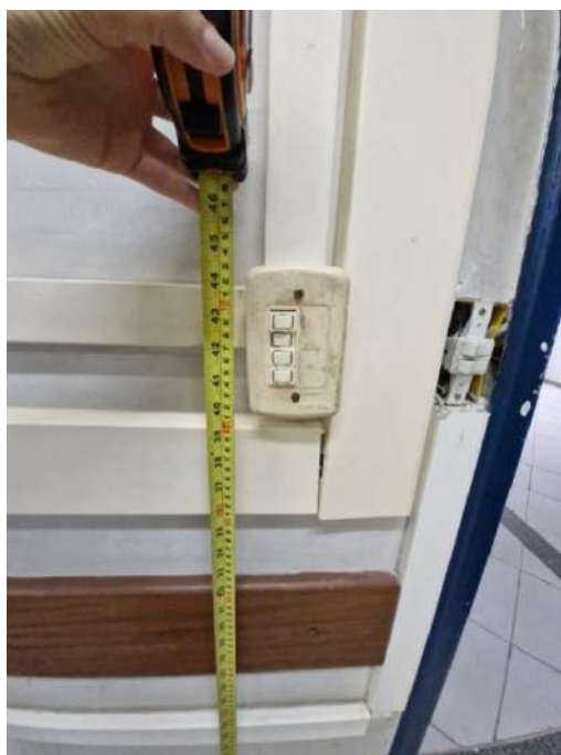
Instalações (Autor do Laudo).
