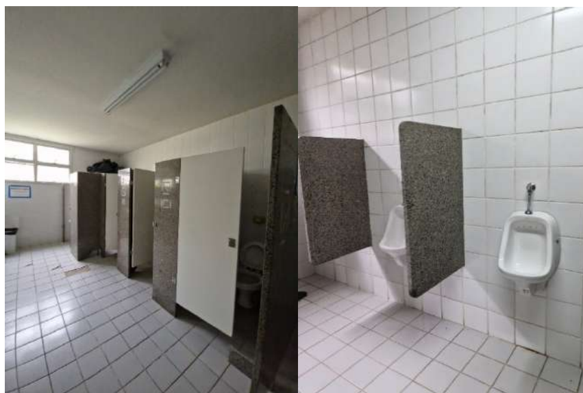
Banheiro de uso coletivo (Autor do laudo)
