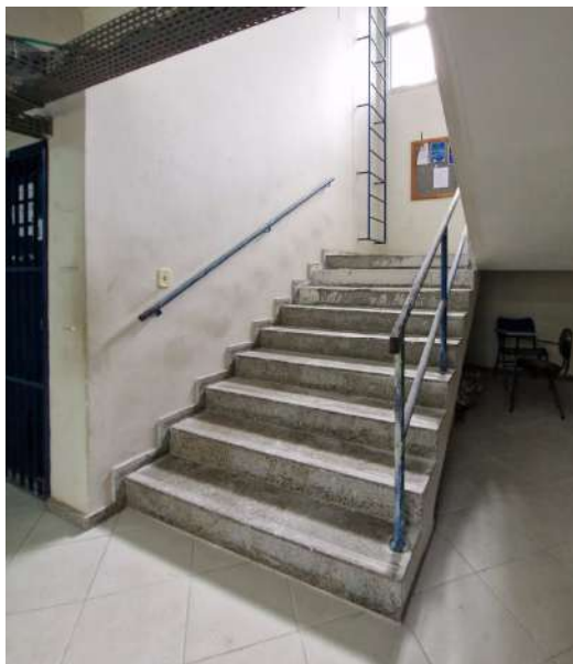
Escada de acesso ao segundo pavimento (Autor do laudo).
