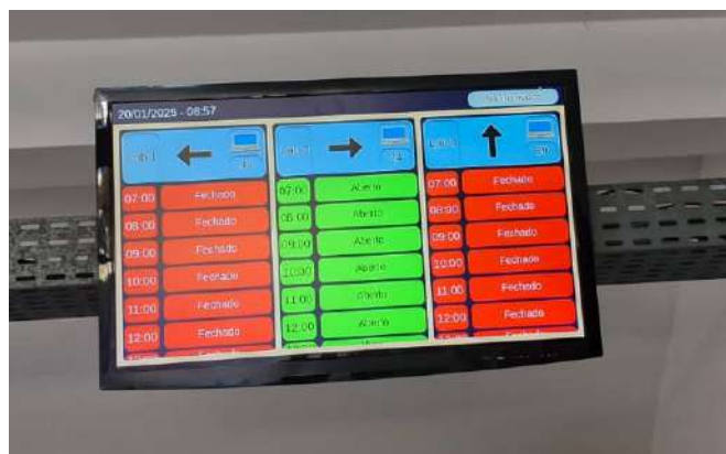
Sinalização dos laboratórios (Autor do laudo).
