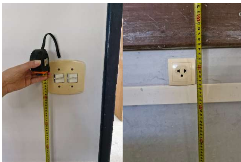
Instalações (Autor do laudo).
