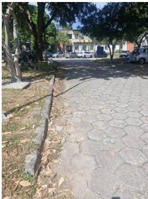
Passeio e acesso à edificação (Autor do laudo).
