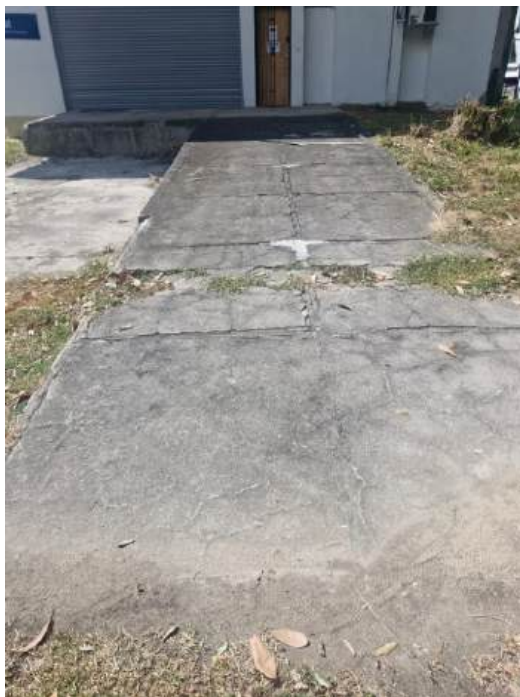
Rampa de acesso a edificação (Autor do laudo).
