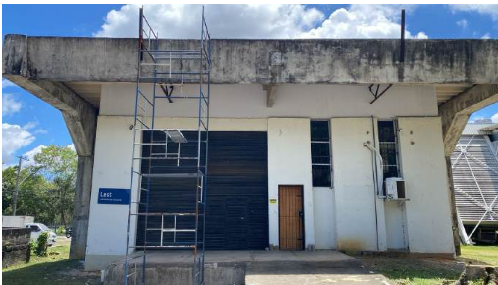
Porta de acesso à edificação (Autor do laudo).
