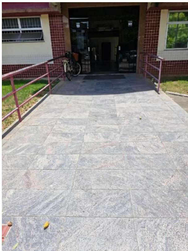
Rampa de acesso à edificação (Autor do laudo).
