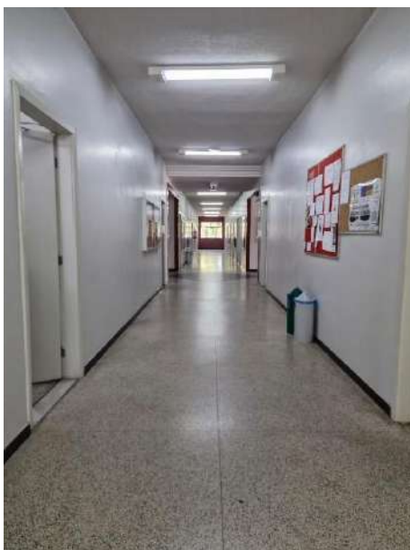
Corredor interno (Autor do laudo).
