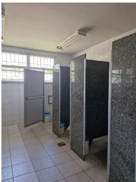
Banheiro de uso coletivo (Autor do laudo)
