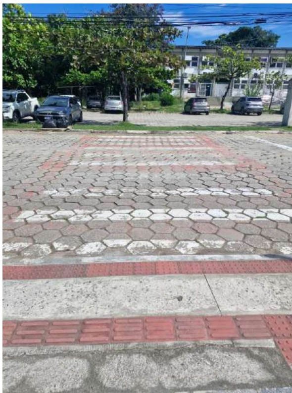
Rota de acesso estacionamento à edificação (Autor do laudo).
