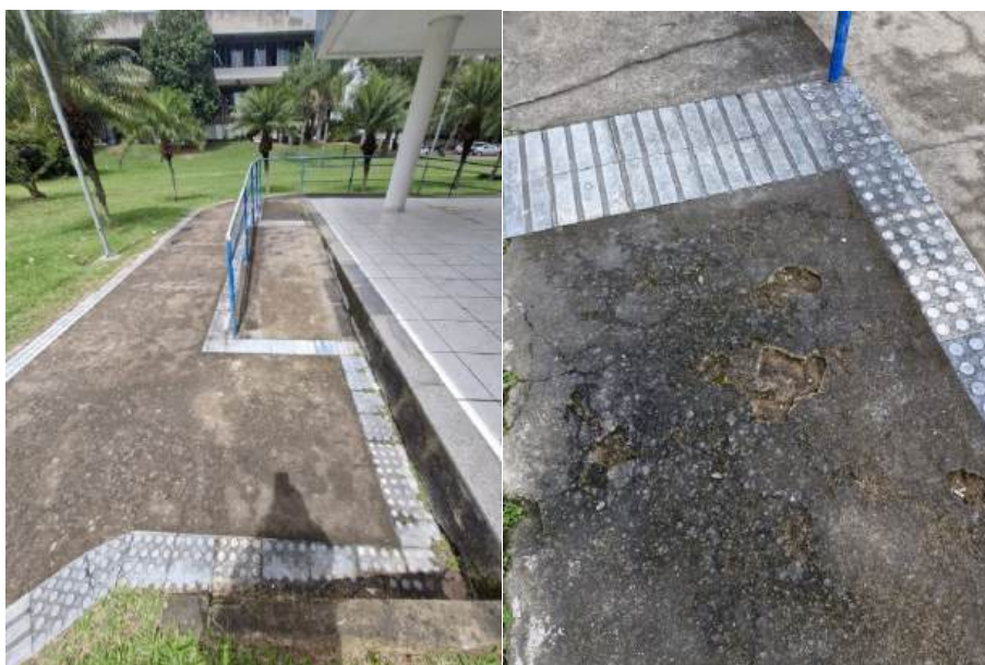
Calçada de acesso à edificação (Autor do laudo).
