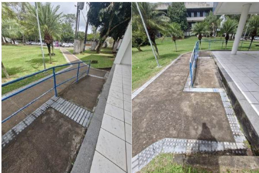
Rampa de acesso a edificação (Autor do laudo).
