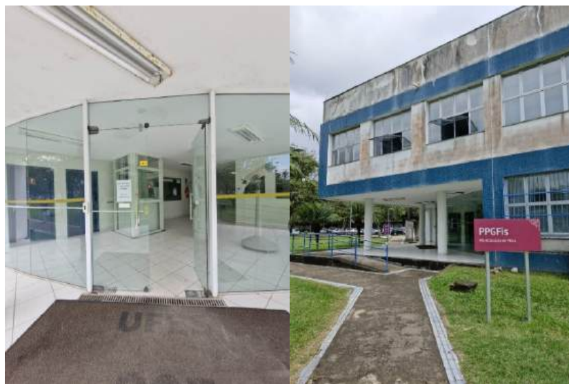
Porta de acesso à edificação (Autor do laudo).
