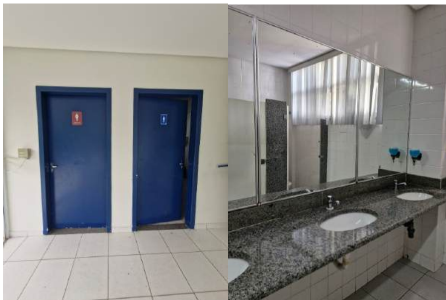
Banheiro de uso coletivo (Autor do laudo)
