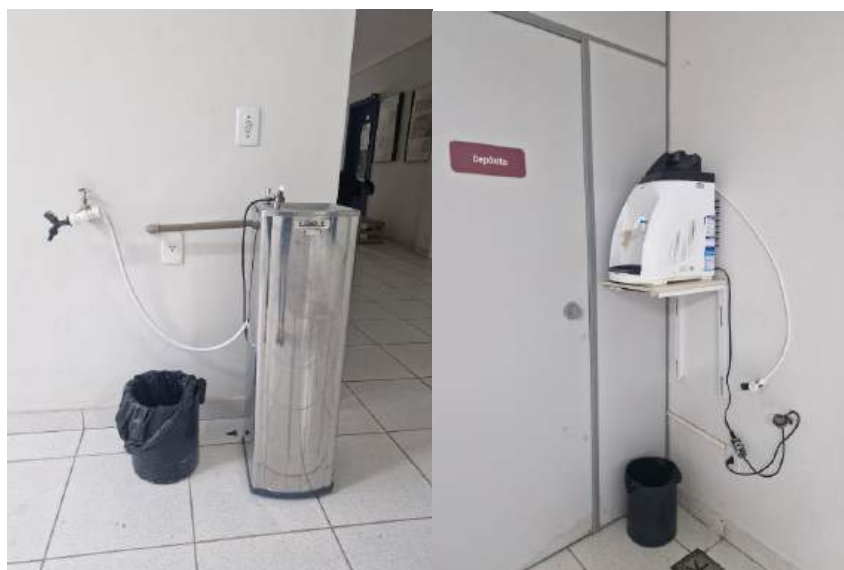
Bebedouros presente no prédio (Autor do laudo).
