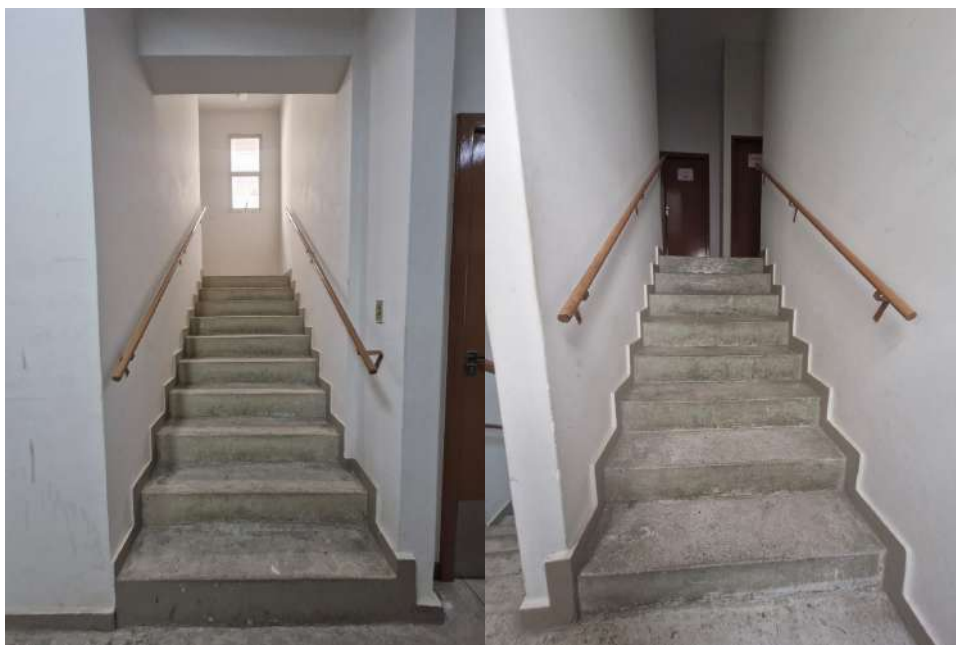
Escada de acesso ao segundo pavimento (Autor do laudo).
