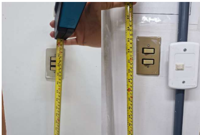
Instalações (Autor do laudo).
