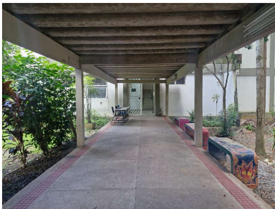
Calçada de Acesso à edificação (Autor do laudo).
