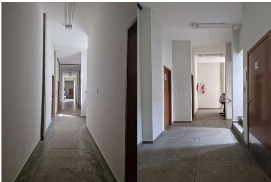
Corredor interno (Autor do laudo).
