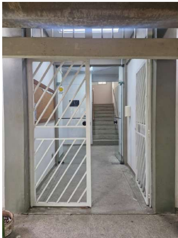
Porta de acesso à edificação (Autor do laudo).
