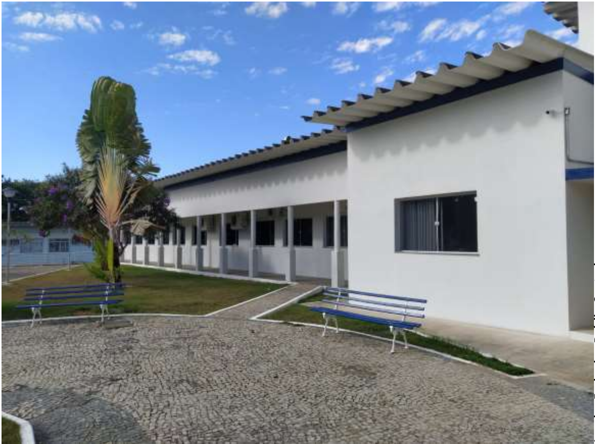
Janelas Fachada: Prédio Central
