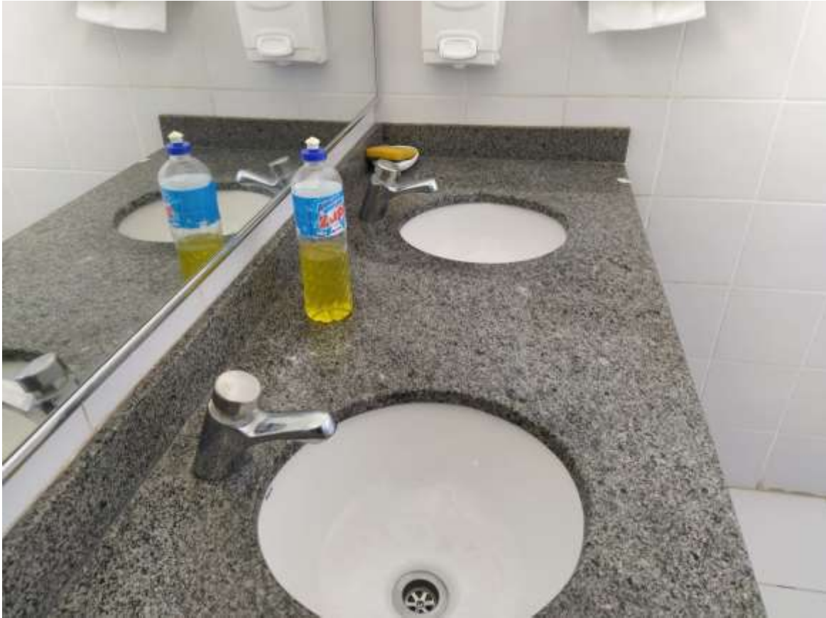
Registro Fotográfico 7. Instalação de torneiras de pressão nos banheiros coletivos
