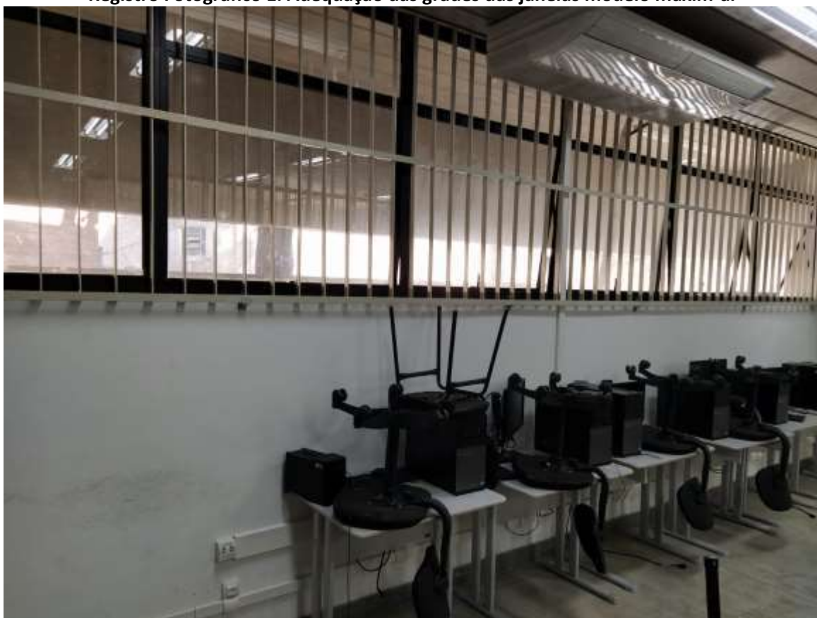
Registro Fotográfico 1. Adequação das grades das janelas modelo maxim-ar
