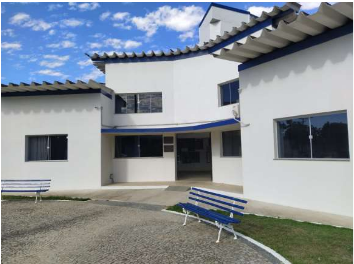
Janelas Fachada: Prédio Central
