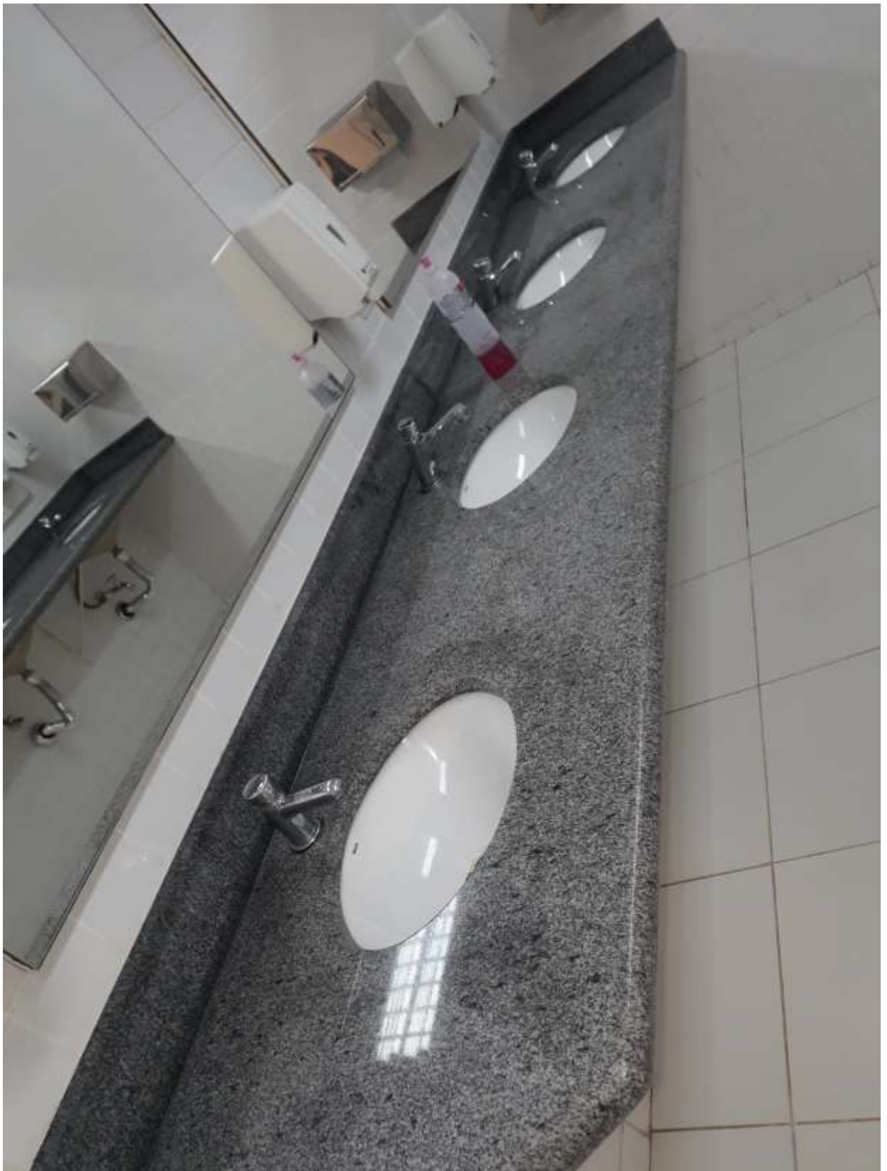
Banheiro: Prédio da Vale
